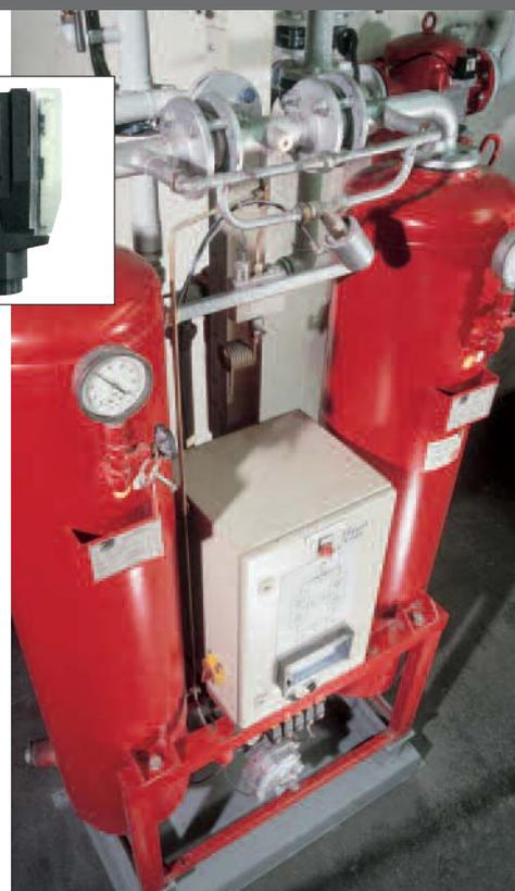
Bei Adsorptionstrocknern überwacht der testo 6740 nicht nur höchst zuverlässig die Restfeuchte, darüber hinaus dient er der optimalen Regelung – geringere Betriebskosten sind die Folge.
