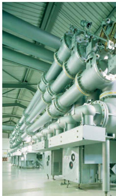
In der Hoch- und Mittelspannung dient  $\text{SF}_6$  zur Vermeidung von Schaltfunken. testo 6740 überwacht kontinuierlich die Feuchte – so können die Austauschzyklen des teuren Gases maximiert werden; Schäden werden vermieden.
