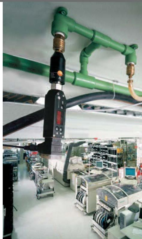
Bei kritischen Anwendungen überwacht der testo 6740 die Druckluftfeuchte direkt vor dem Verbraucher – z.B. in der Elektronikfertigung.
